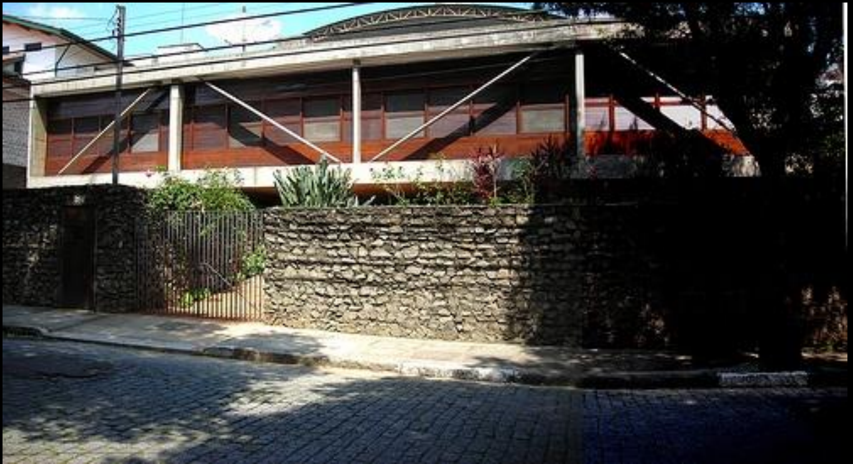
Residência Manoel Mendes Andre 1966
