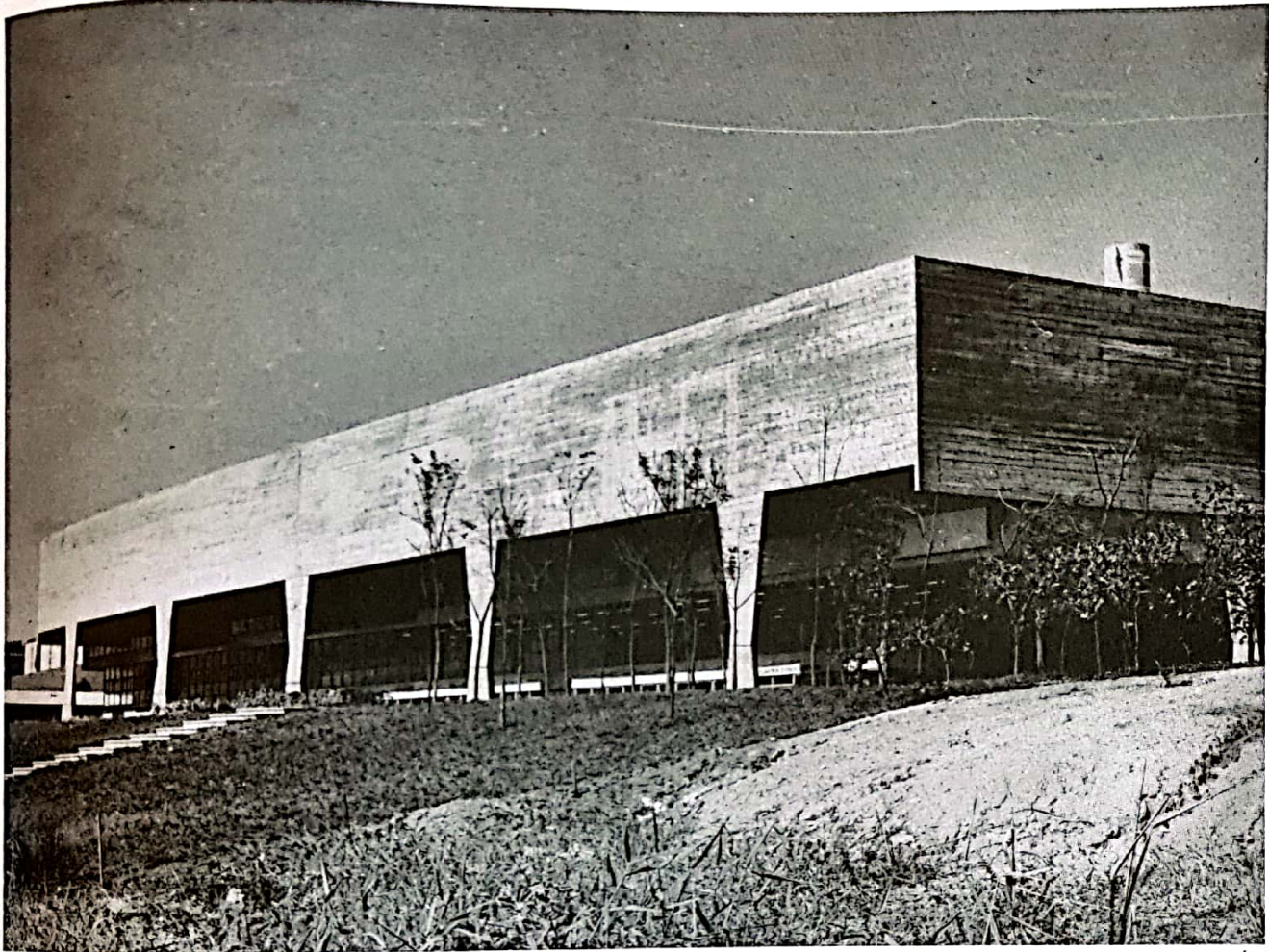
Fig. 284. João VILANOVA ARTIGAS. Faculdade de Arquitetura e Urbanismo . São Paulo. 1961-1969. Exterior. Frente sul.
