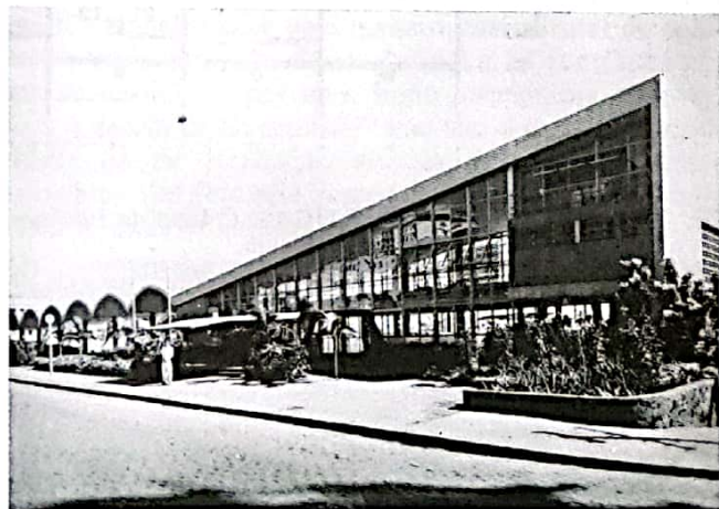
Fig. 276. João VILANOVA ARTIGAS. Estação Rodoviária. Londrina (Paraná). 1951.
