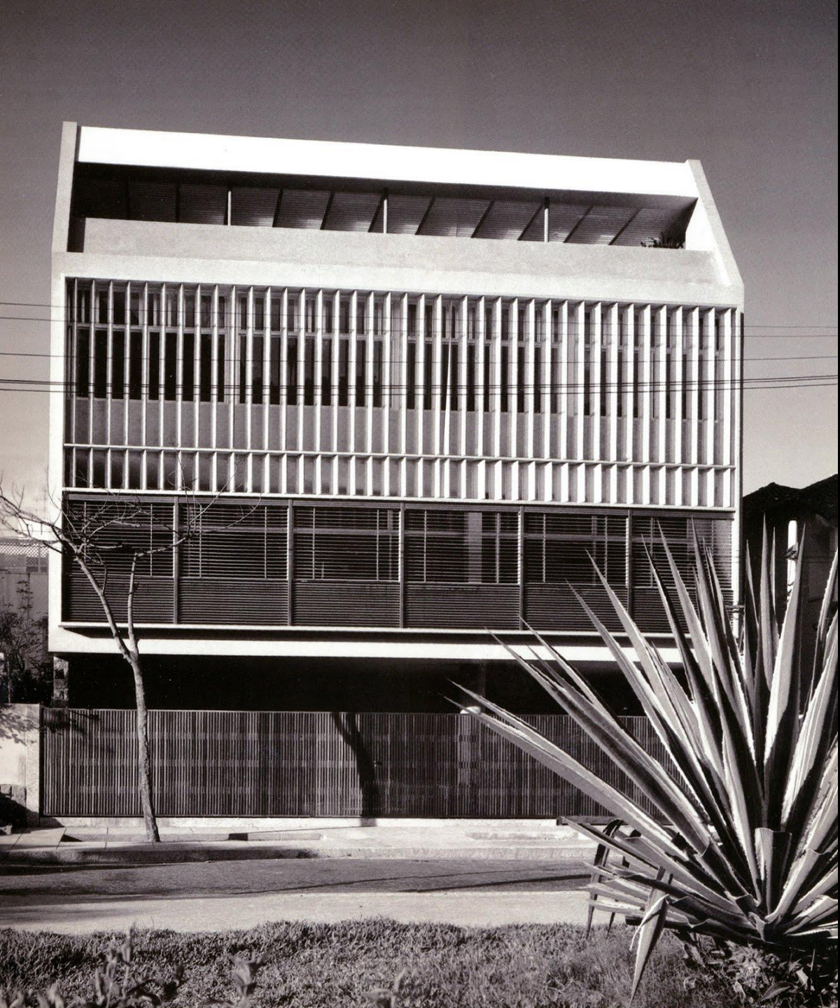
Residência Antonio Ceppas 1951-58
