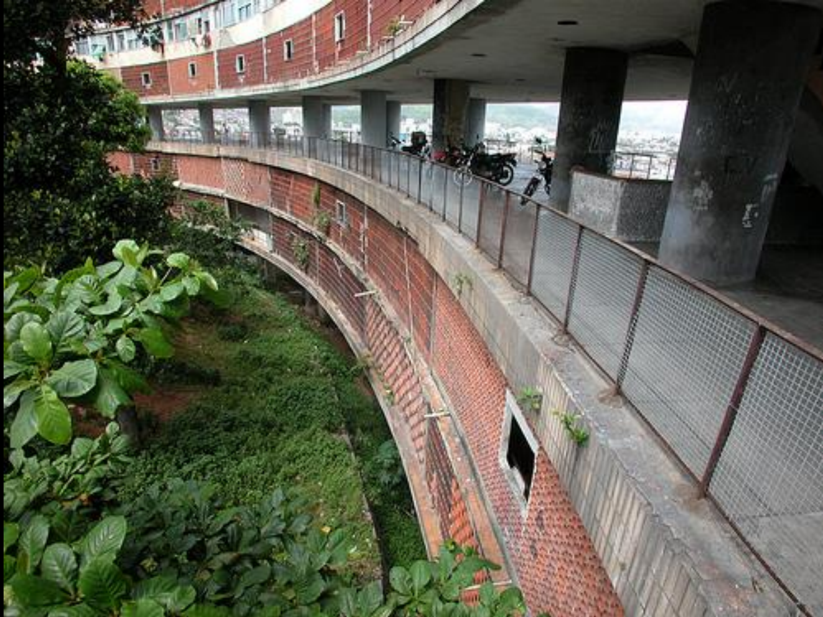
Conjunto Residencial Mendes de Moraes (Pedregulho) – Bairro Benfica – Rio de Janeiro
