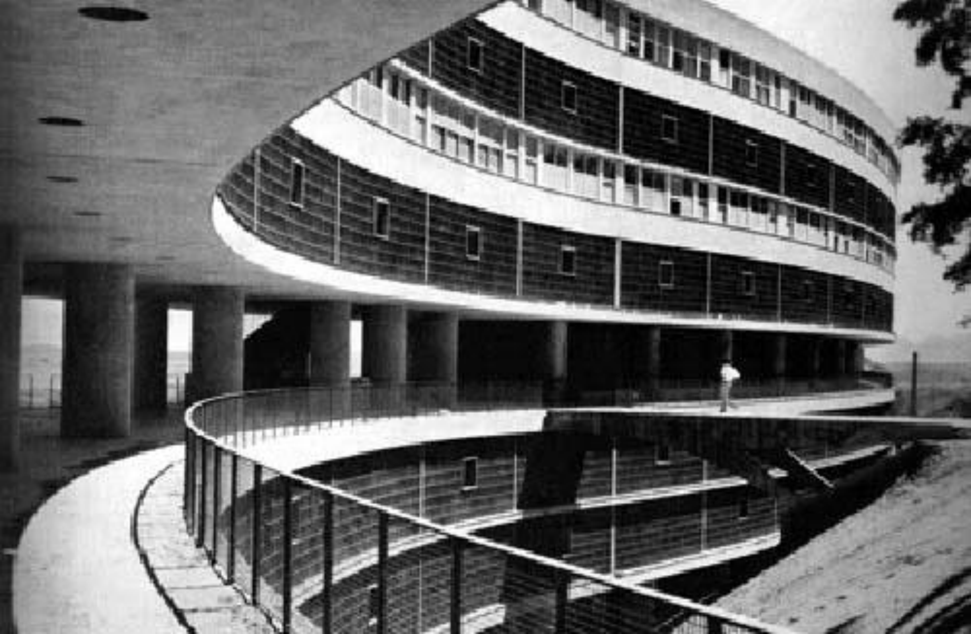
Conjunto Residencial Mendes de Moraes (Pedregulho) – Bairro Benfica – Rio de Janeiro
