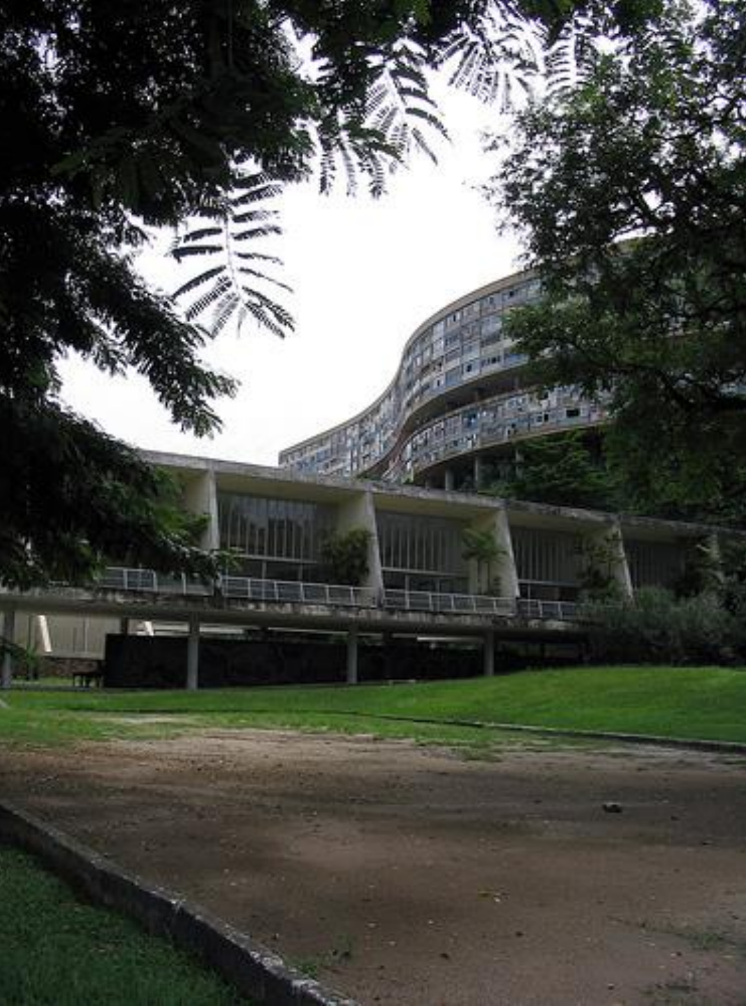
Conjunto Residencial Mendes de Moraes (Pedregulho) – Bairro Benfica – Rio de Janeiro
