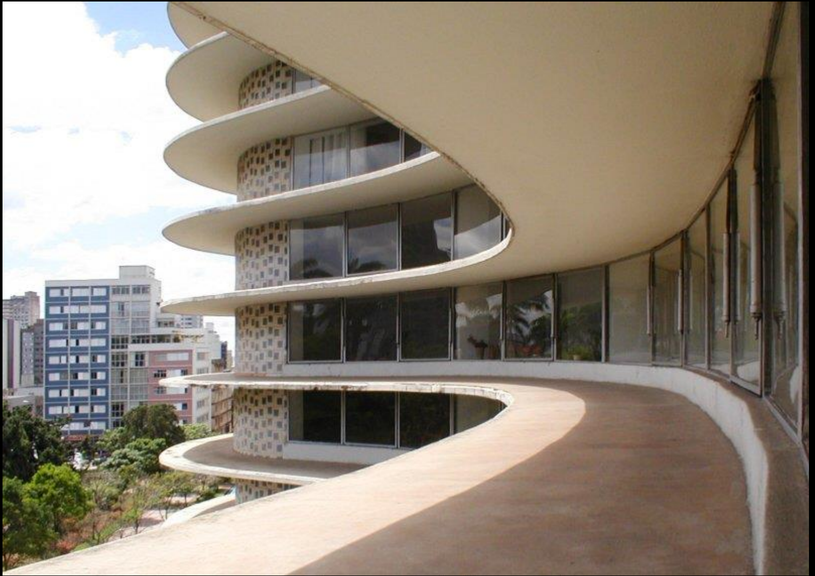
Edifício Niemeyer – Belo Horizonte 1954-60
