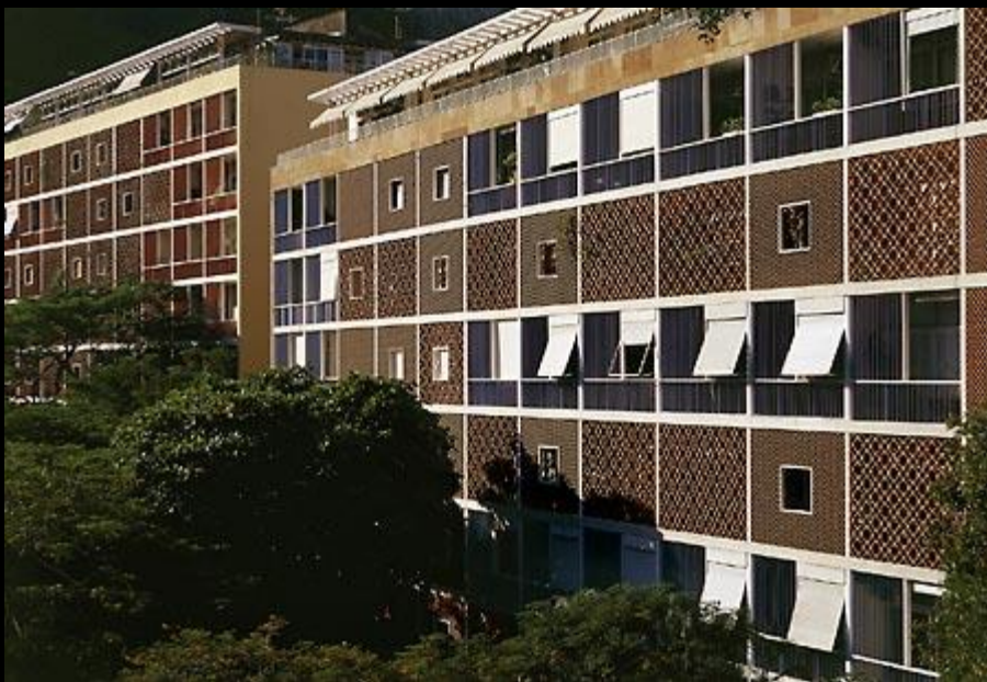
Conjunto Residencial do Parque Guinle 1948-54
