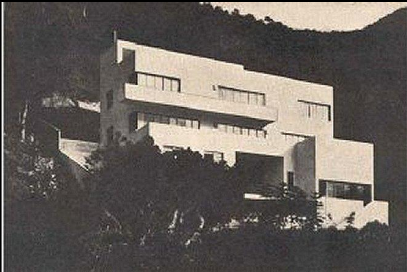
Residência Nordchild Rua Toneleros – Rio de Janeiro Demolida em 1990
