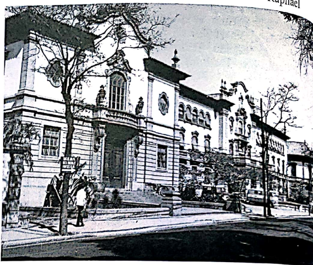
Fig. 23. Ângelo BRUHNS e José CORTEZ. Escola Normal (hoje Instituto de Educação). Rio de Janeiro. 1926-1930. Fachada.
