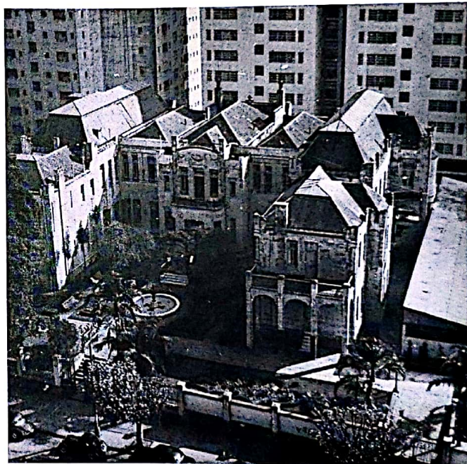
Fig. 8. Karl EKMAN. Casa Álvares Penteado, 1902. Estado atual, esmagada pelos prédios que a circundam.
