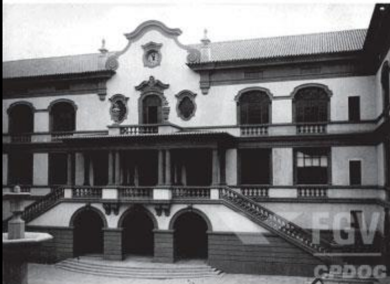
Figura 1: Aspecto interno do prédio do Instituto de Educação do Rio de Janeiro
